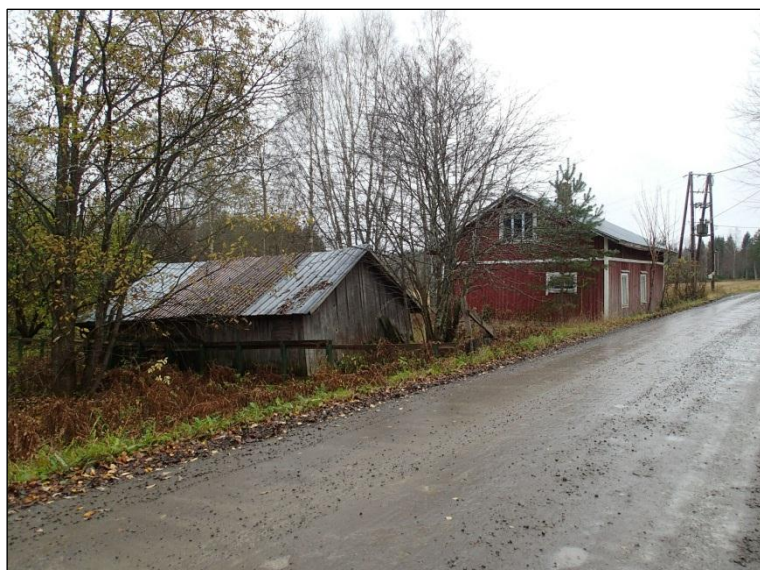
Tutkimusalueen rakennettua ja muokattua pihapiiriä pellon itäpuolella. Länteen..
